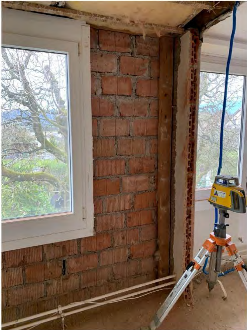
neue Wandöffnung für Durchgang Masterbad - Schlafzimmer
