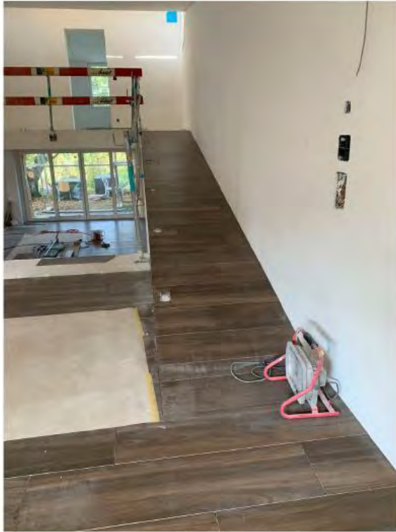
Verlegung neuer Bodenbelag
